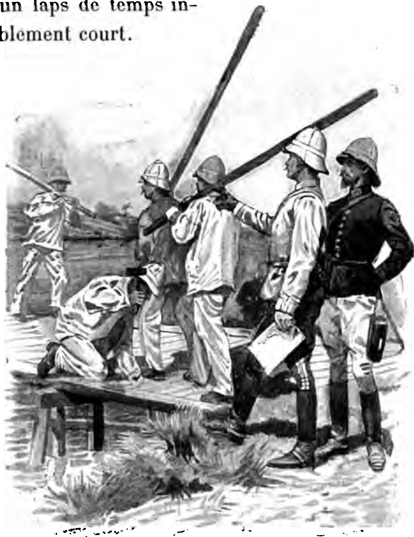
• Le génie construit un pont. •
