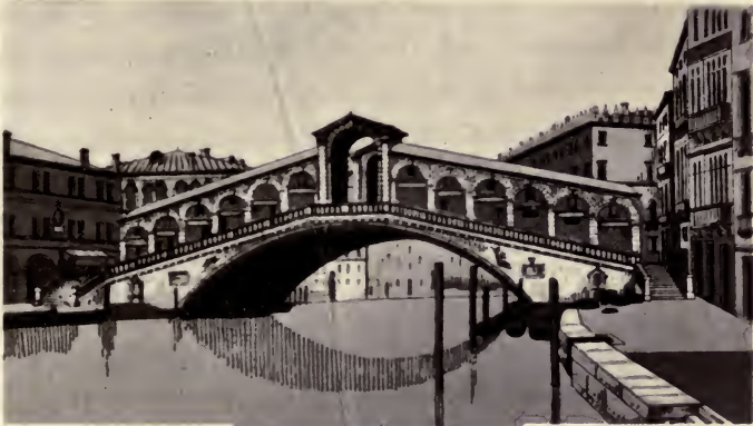
PONTE DI RIALTO
