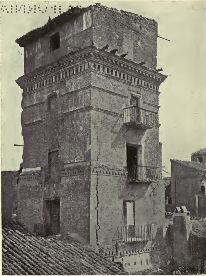
TOWER OF THE CALLE DE ANTONIO PEREZ ZARAGOZA
