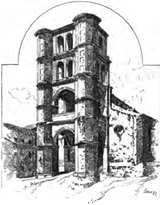
ANTIGUA TORRE DE SAN BENITO
