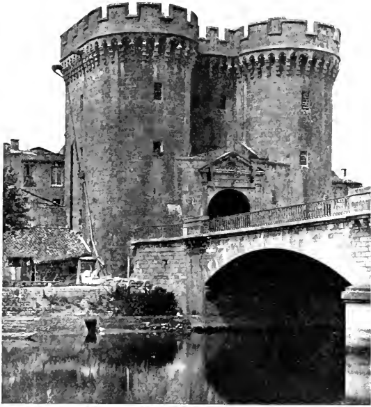
THE PORTE CHAUSSÉE (before the war).
