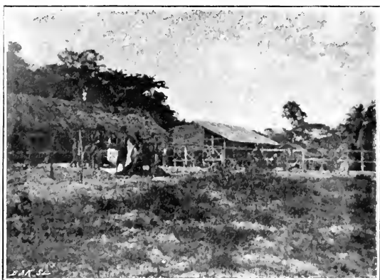
MACABANDILOU LE POSTE
