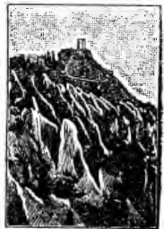
Erosione (Castel d'Aspio, Ventimiglia).
