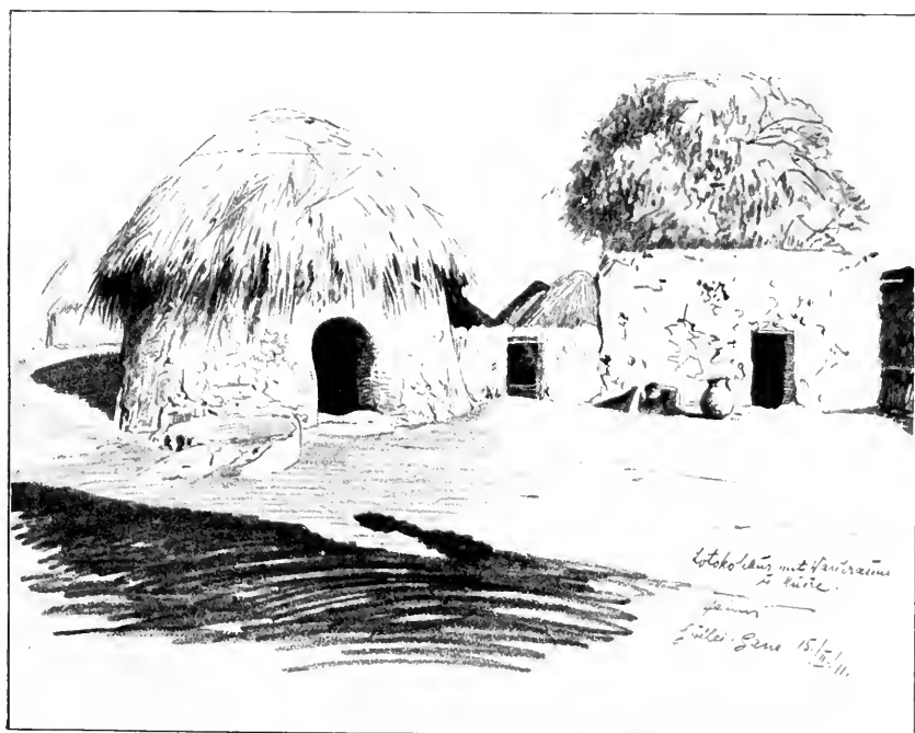
137. Rotokohaus in Gulfei, mit Waschraum und Rüche. (S. 179.)
