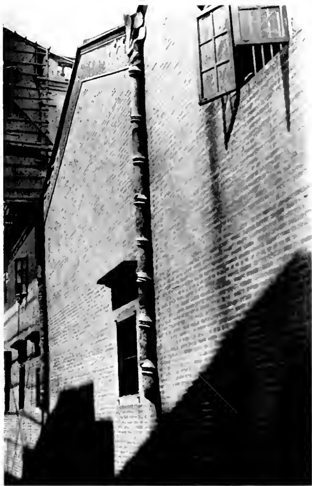
Kanton, neues Westviertel: Gosse in Form eines Bambusstammes
