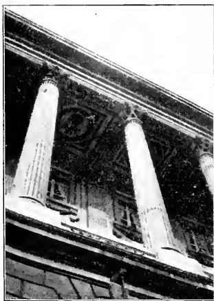
Abb. 197 Detail vom Garde-meubles in Paris
