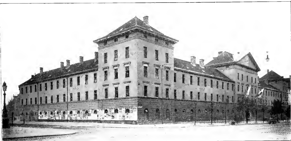
Abb. 106 Alte Schwere Reiter-Kaserne in München
