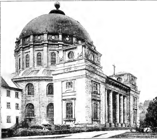
(Phot. Joh. Elchlepp, Freiburg i. B.) Abb. 21 Benediktinerabteikirche in St. Blasien
