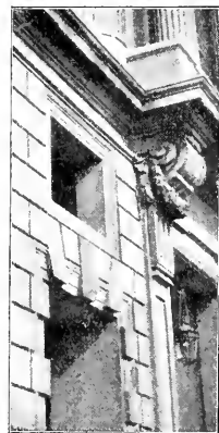
Abb. 198 Detail vom Garde-meubles in Paris
