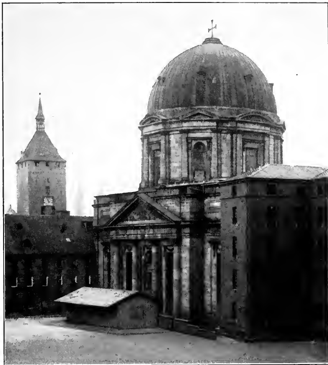
Abb. 23 Deutschhauskirche in Nürnberg
