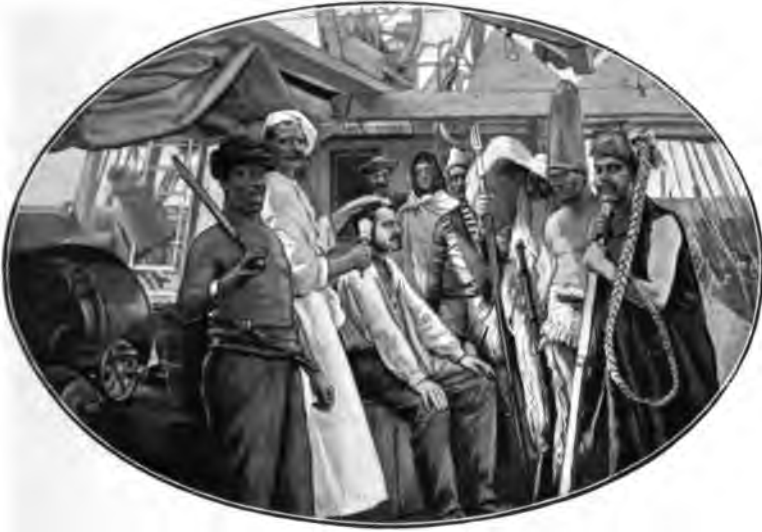
PASSAGE DE LA LIGNE.
