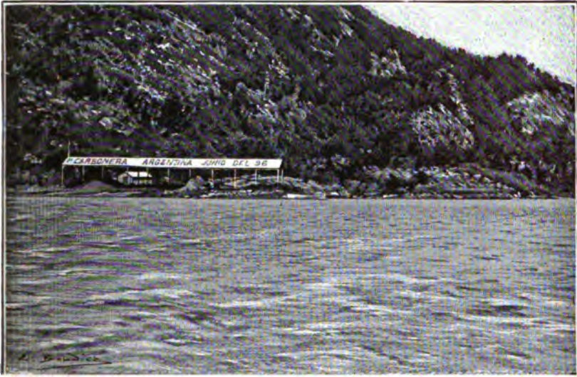
DÉPÔT DE CHARBON DE LA MARINE ARGENTINE A LAPATAÏA.
