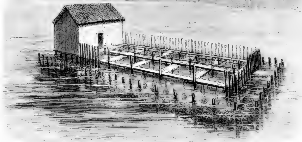
Fig. 10. Réserve ou parc de dépôt, établi en pleine eau, précédé d'un hangar destiné à recevoir les instruments d'exploitation. L'enceinte de perches du côté droit a été en partie supprimée pour montrer la disposition du plancher, et les paniers d'huîtres qui y sont suspendus.
