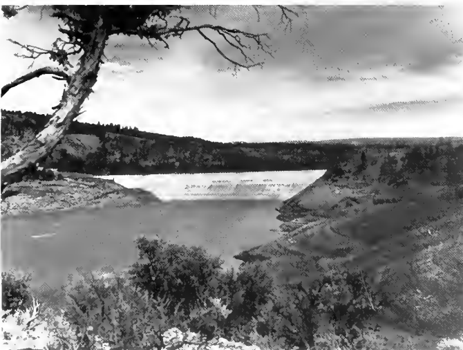
El Vado Dam
