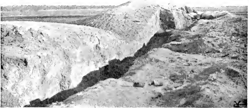
Abb. 93: Das nördliche Ende der inneren Stadtmauer von Südost.
