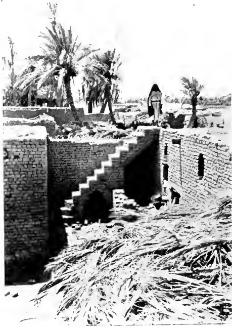
Abb. 238: Dachtreppe im Dorfe Kweiresch.
