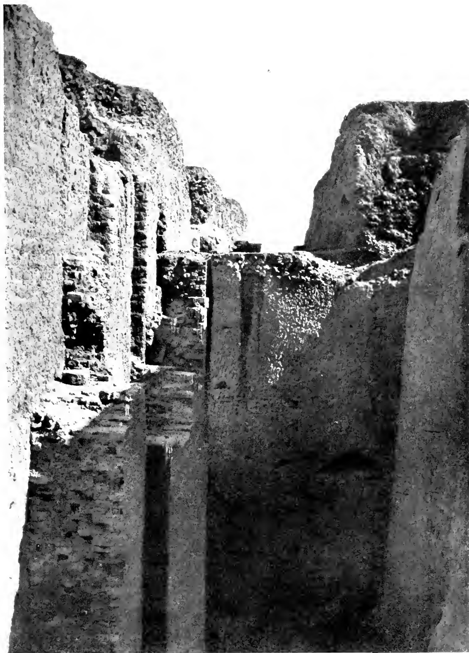
Abb. 92: Zwischenraum zwischen den beiden Lehmmauern. Koldewey, Babylon.
