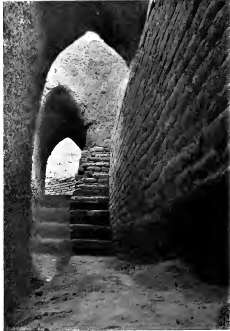
Abb. 35: Kanal südlich vom Kasr.
