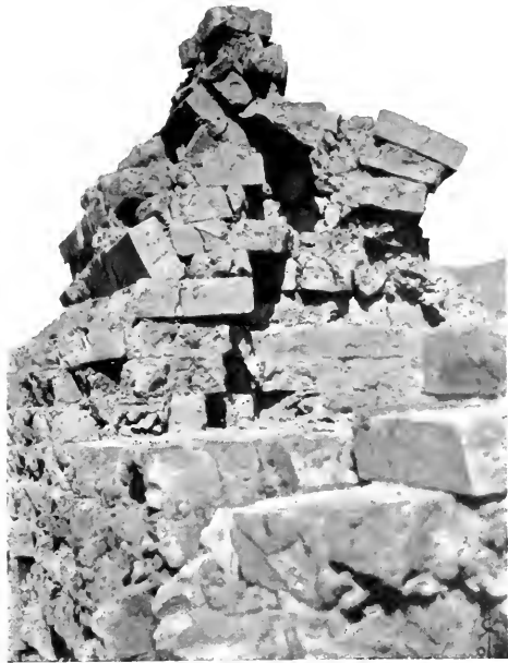
Abb. 61: Bogenansätze vom Gewölbebau.
