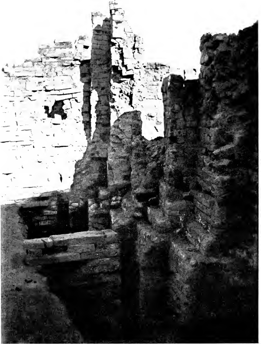
Abb. 69: Nordwand des Nabopolassar-Palastes.
