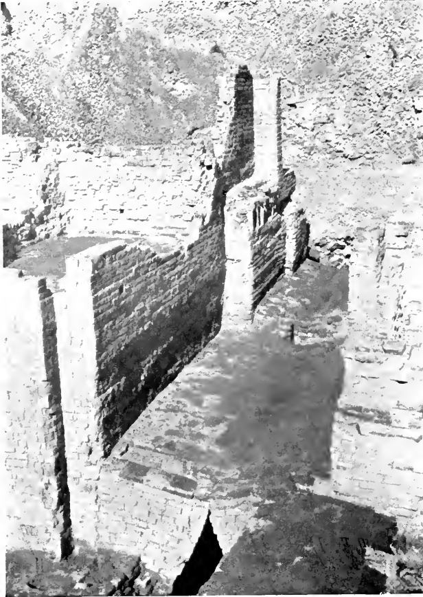
Abb. 106: Pforte mit Kanal in der Nordmauer der Hauptburg.
