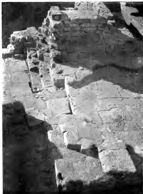
Abb. 22: Genutete Dilatationsfuge am Ischtar-Tor.
