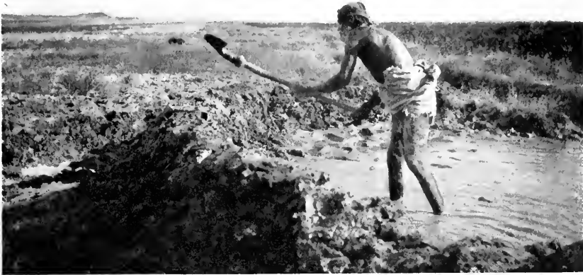
Abb. 10: Araber beim Kanalbau auf dem Stadtgebiet von Babylon.
