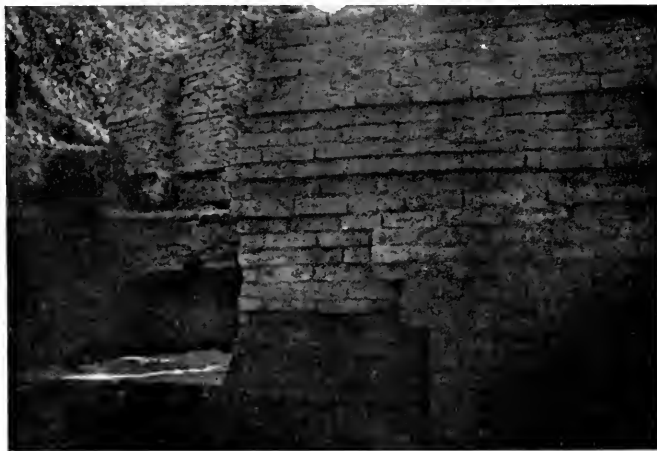
Abb. 74: Fundament der Festungsmauer im Norden der Südburg.
