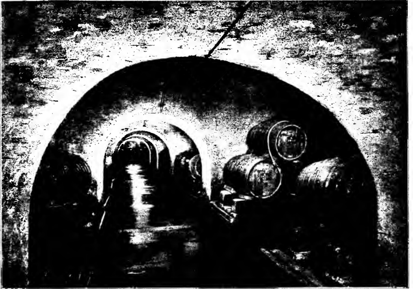
Verbindungsgang im Hauptkeller
