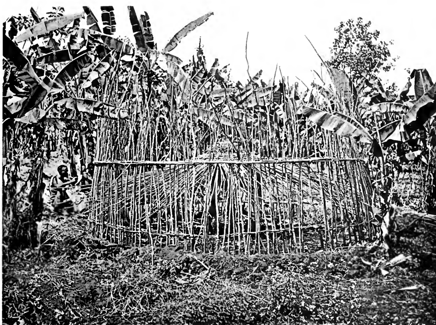
Hausbau in Kissaka.
