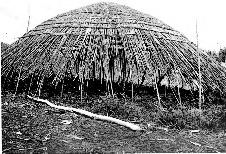
Hütte im Bau. Toro.
