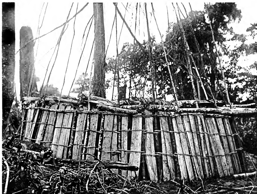
Banyari-Hütte im Bau. Kitumbi.
