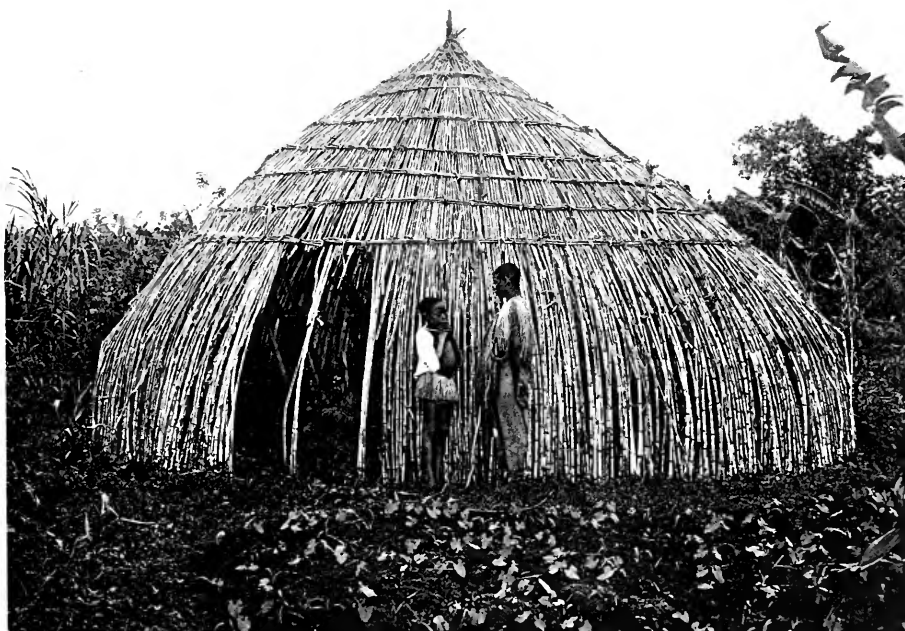
Hütte im Bau. Kiziba.
