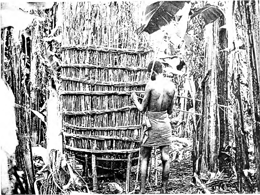
Herstellung eines Vorratshauses in Kissaka.
