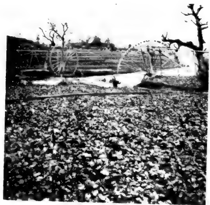
照片 77 銅仁麻陽江沿岸的主要灌溉方式——筒車灌溉
