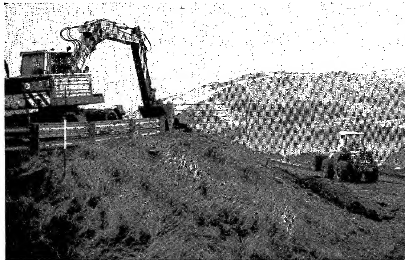
Zonder de uitslag van de gemeentelijke AROB-procedure tegen de afwijzing van een bocht in het circuit door de provincie af te wachten, is de Cenav met de aanleg van de nieuwe S-bocht begonnen. Ook van ontgronding blijkt geen sprake te zijn, want er wordt juist zand aangevoerd.
