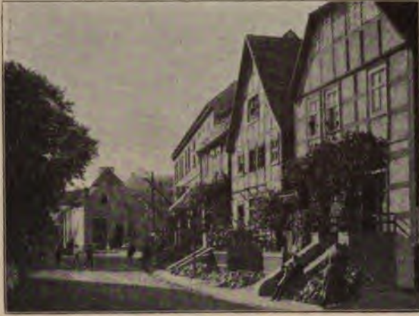
Altstadt Oderberg, „Berliner Straße“. (An der ehemaligen Niederlage.)
