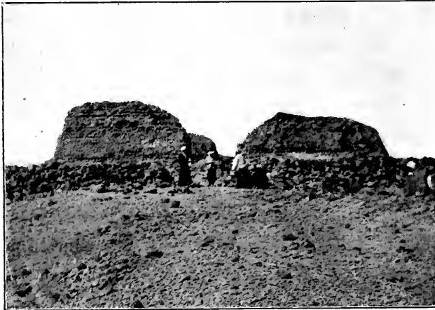
Ansicht des Tempels von Osten.
