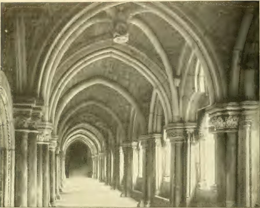
Abb. 6. Westlicher Arm im Kreuzgang des St. Michaelisklosters zu Hildesheim. Innere Ansicht von Süden aus.
