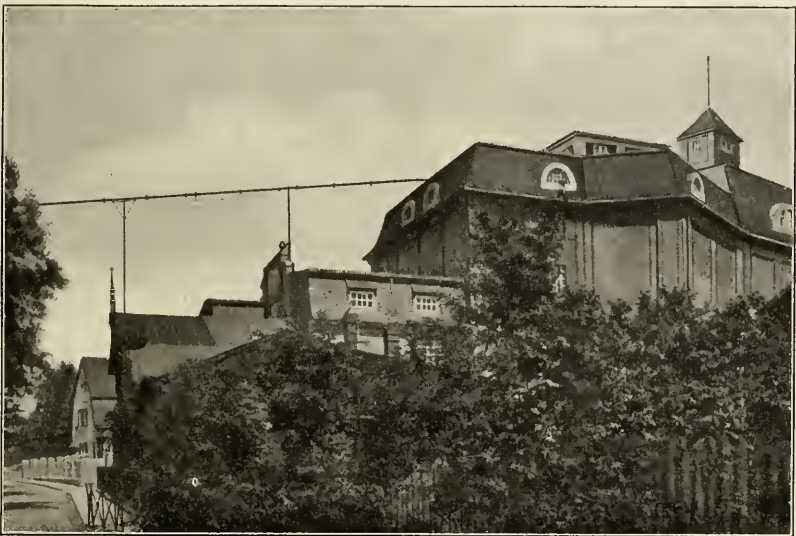
Fig. 25. Silospeicher mit einem Fassungsvermögen von 40000 Zentnern (2000000 kg). Die Beschickung findet durch die in der Abbildung sichtbare Rohrleitung statt.
