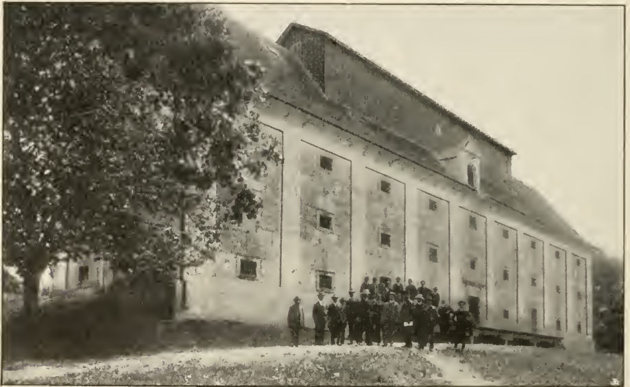
Fig. 2. Getreidespeicher der gräfl. Piattischen Saatzuchtwirtschaft Loosdorf, Aussenansicht. Aufnahme, gelegentlich des Besuchs von Teilnehmern des 8. internat. landw. Kongresses.
