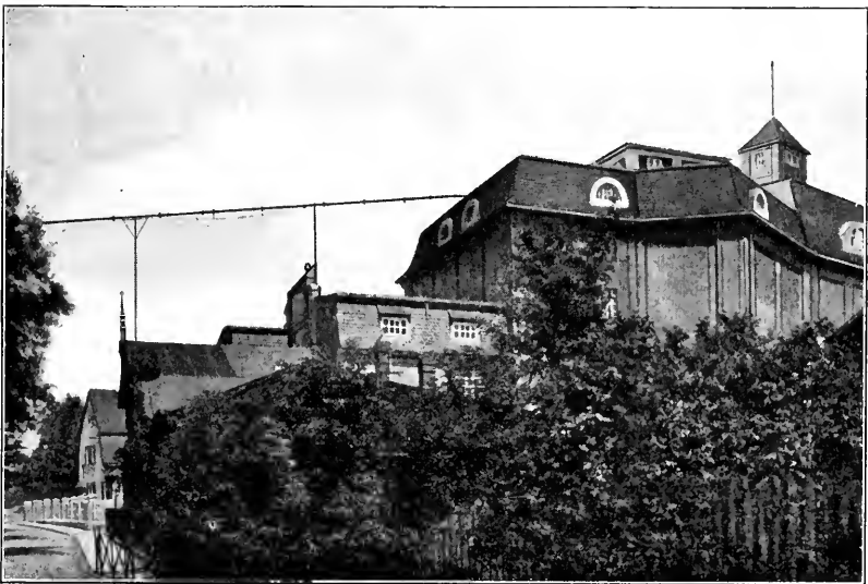
Fig. 25. Silospeicher mit einem Fassungsvermögen von 40000 Zentnern (2000000 kg). Die Beschickung findet durch die in der Abbildung sichtbare Rohrleitung statt.
