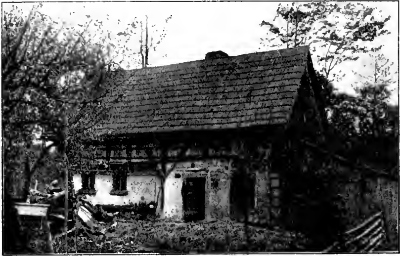
Abb. 4. Haus mit Drempegeschoss. Blumendorf bei Hirschberg Nr. 96.
