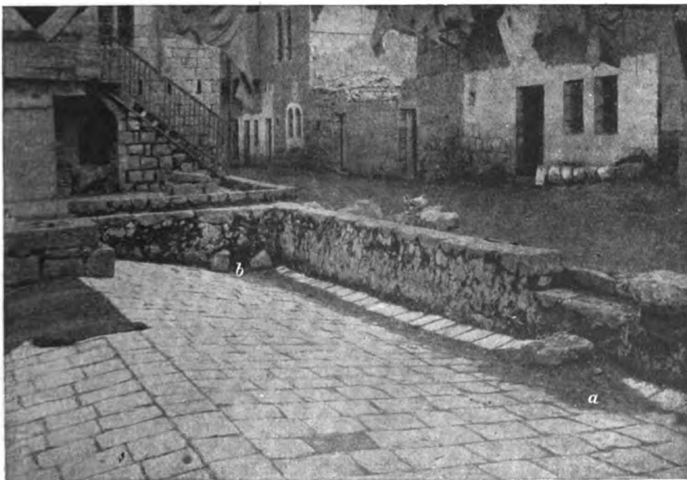
Fig. 15. Zisterne Méah Schéarim. Auf der Zisterne Straßenschmutz a . Links Öffnung in der Zisterne b .
