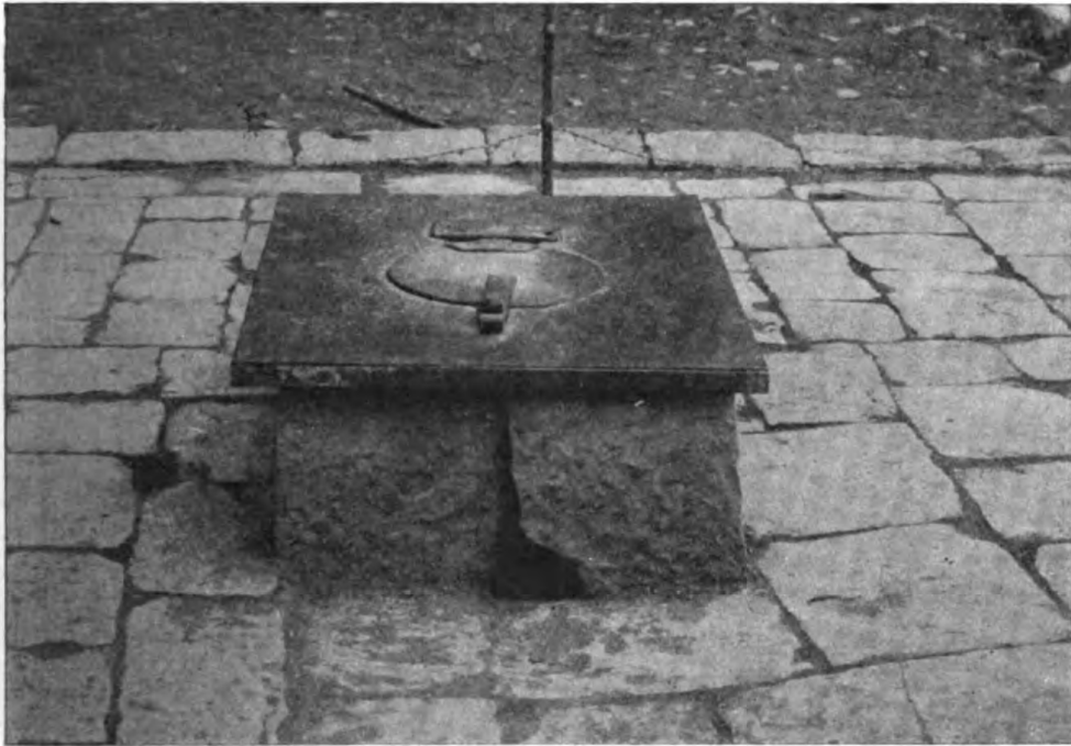
Fig. 18. Gut geschlossene Zisterne mit einem Loch im Aufbau.
