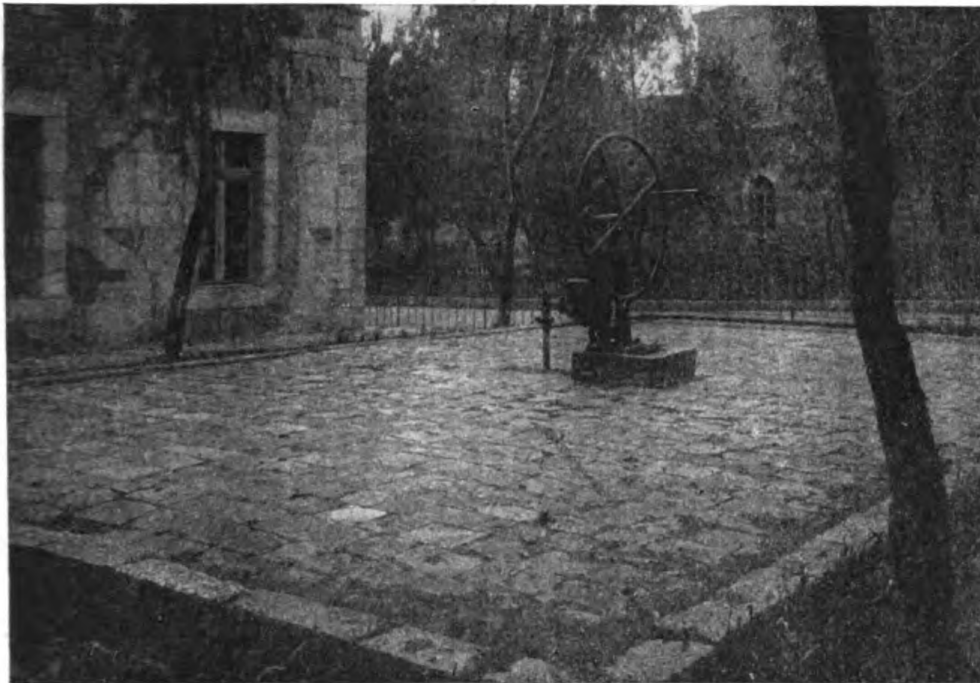
Fig. 6. Gut gebaute Zisterne mit Pumpe; daneben alte Schöpföffnung mit Drahtgitter verschlossen.
