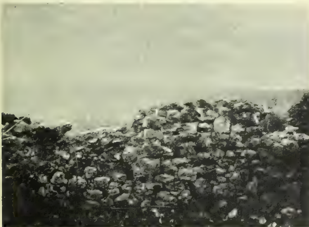
Fig. 6 Die stadtseitige Fassade der Stadtmauer im SW.
