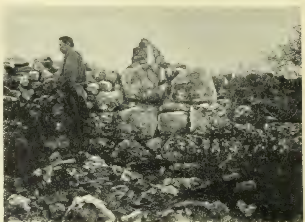
Fig. 8 Turmmauerwerk im NO. (Links oben neu aufgeschichtet.)
