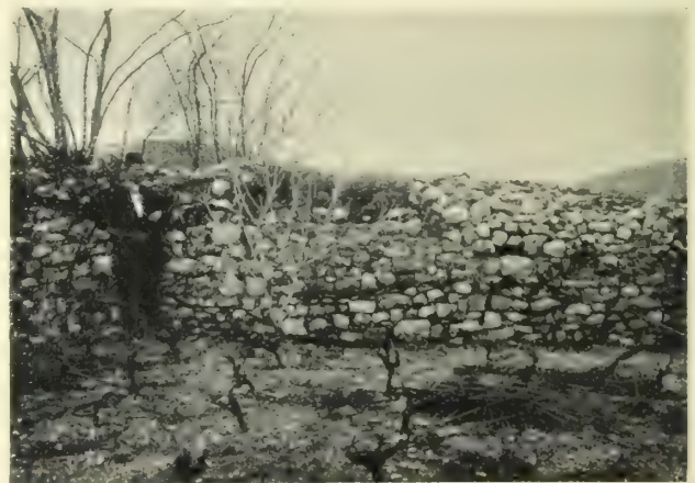
Fig. 4 Die stadtseitige Fassade der Stadtmauer im NO. (Rechts oben neu aufgeschichtet.)
