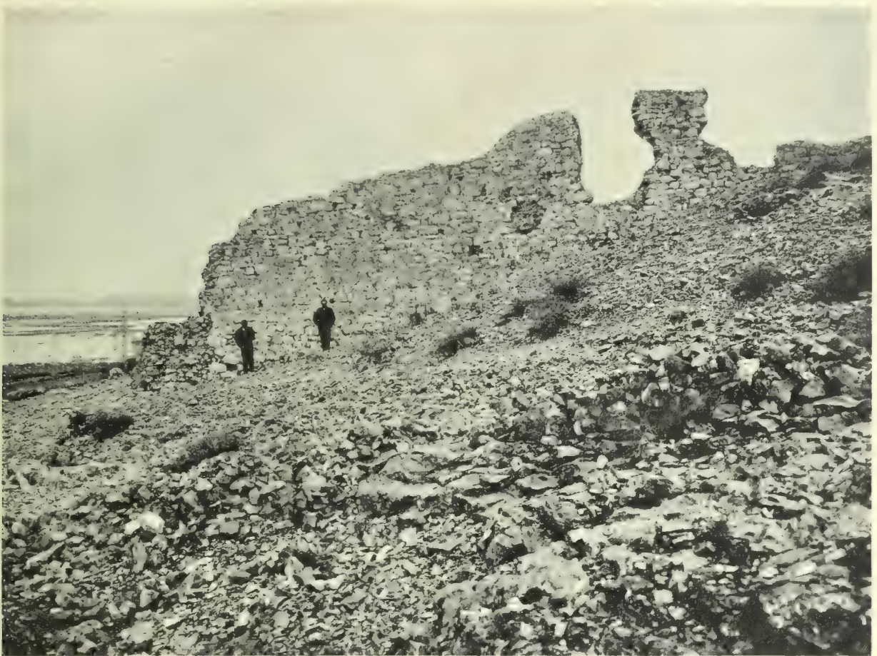
Fig. 5 Die landseitige Fassade der Stadtmauer (A) im NO.
