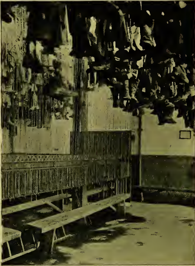
Fig. 22. Entkleidungsraum im Mannschaftsbad zu Zauckerode. (Nach einer Aufnahme aus dem Atelier Schaul, Hamburg.) Die Kleider der Badenden werden mittels einer sinnreichen Schuttr- vorrichtung in die Höhe gezogen und desinfiziert.
