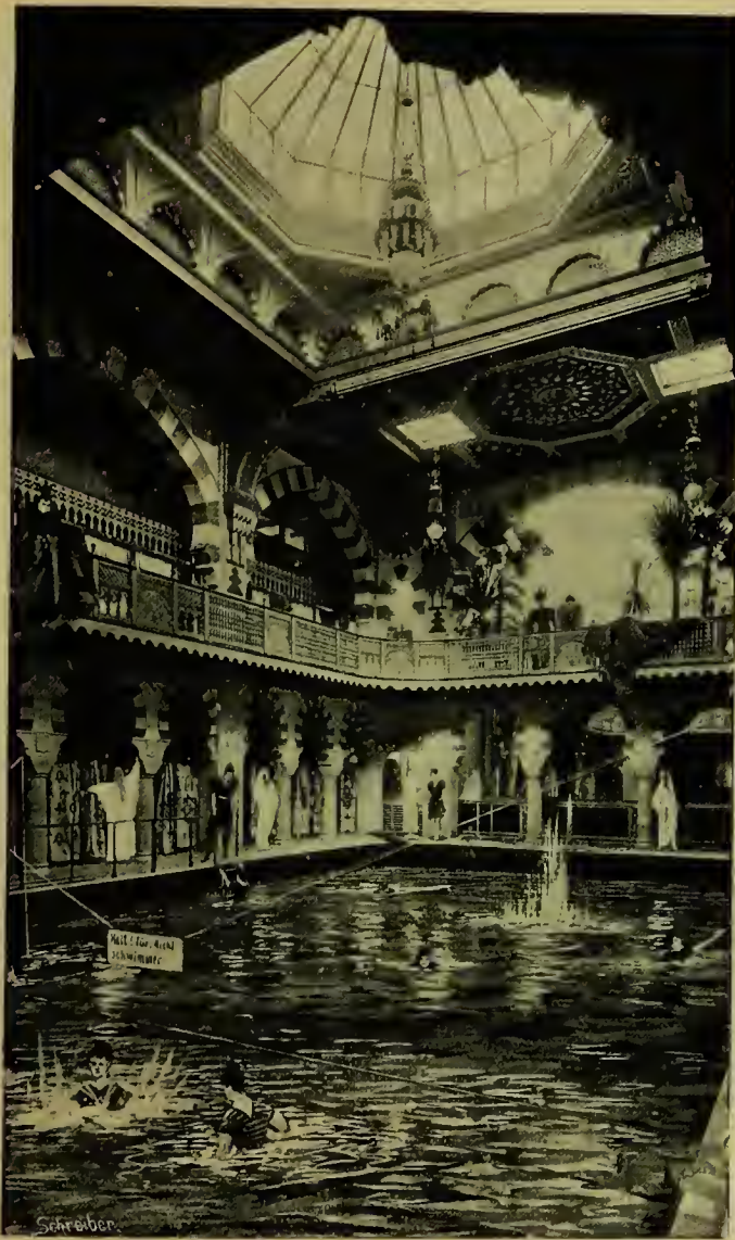
Fig. 17. Stuttgarter Schwimmbad: Frauenschwimmbad.
