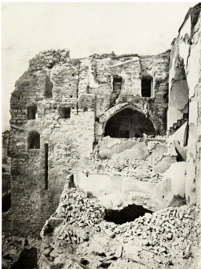
Pavillon d'escalier. Façade Nord.
