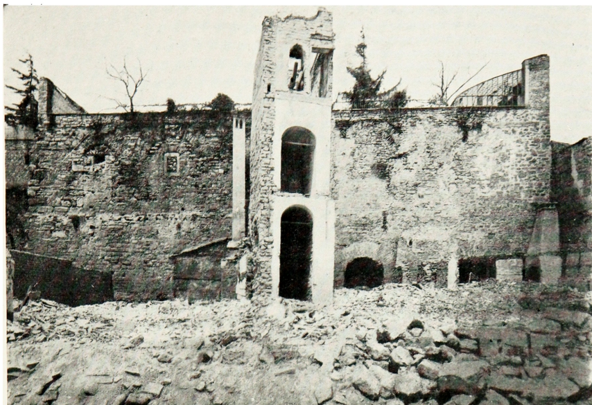
1. Ruines du Grand Palais. Terrasse.
