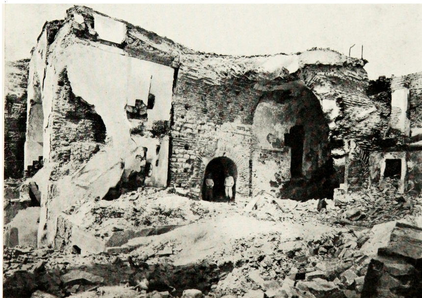
2. Grandes voûtes en berceau près du Pavillon d'escalier.
