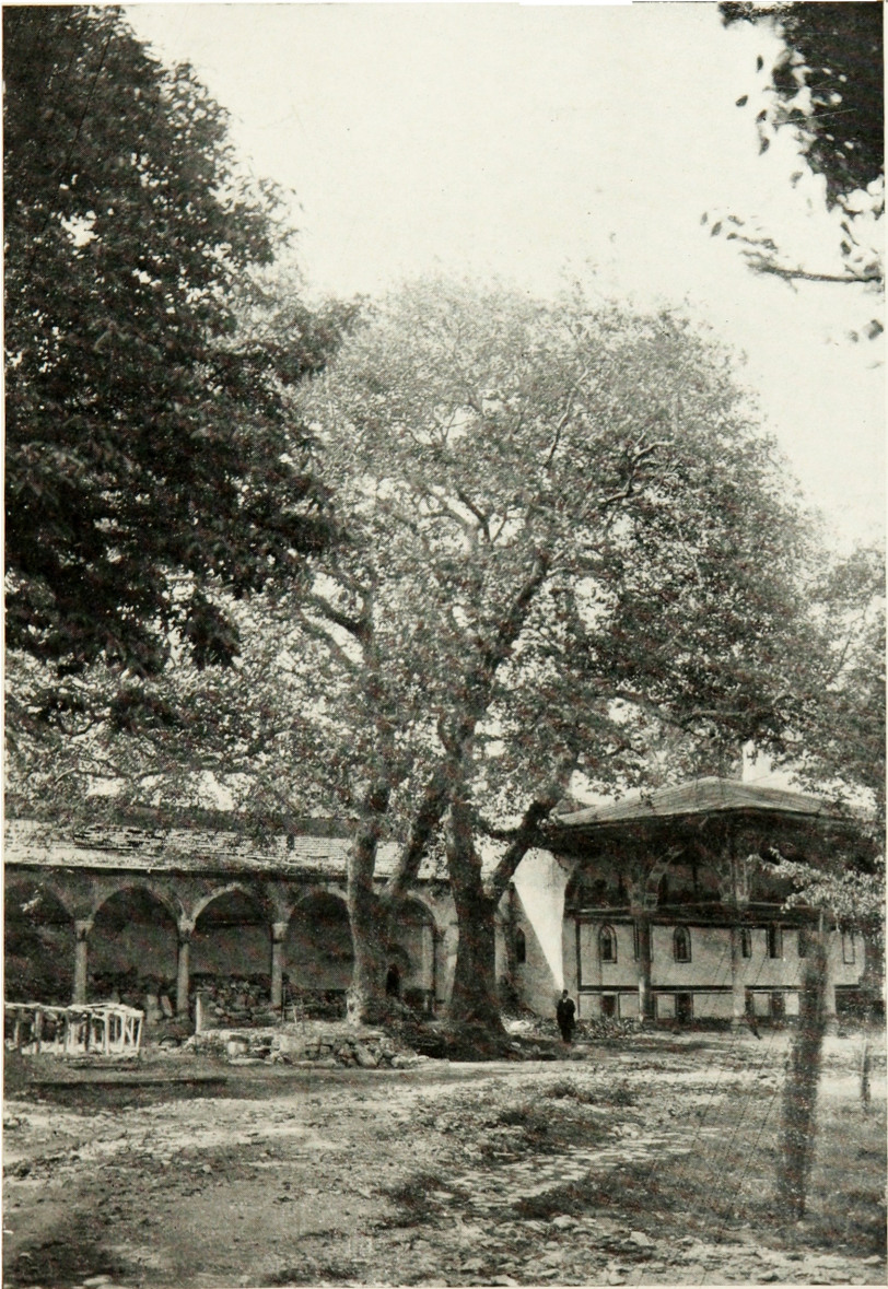
Emplacement de la fouille dans la seconde cour du Sérail.
