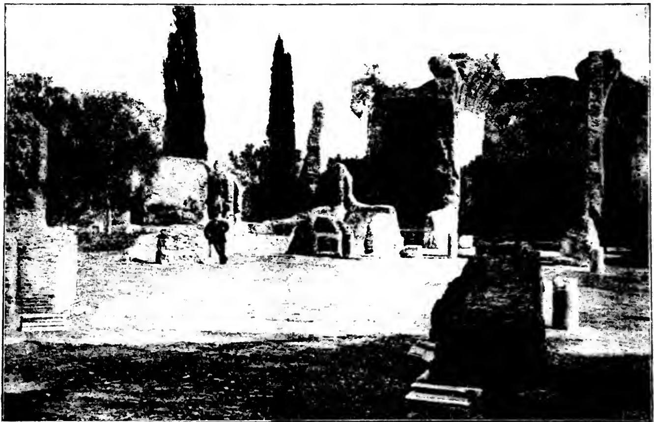
Abb. 4. Der Kuppelsaal und östliche Nebenräume.
