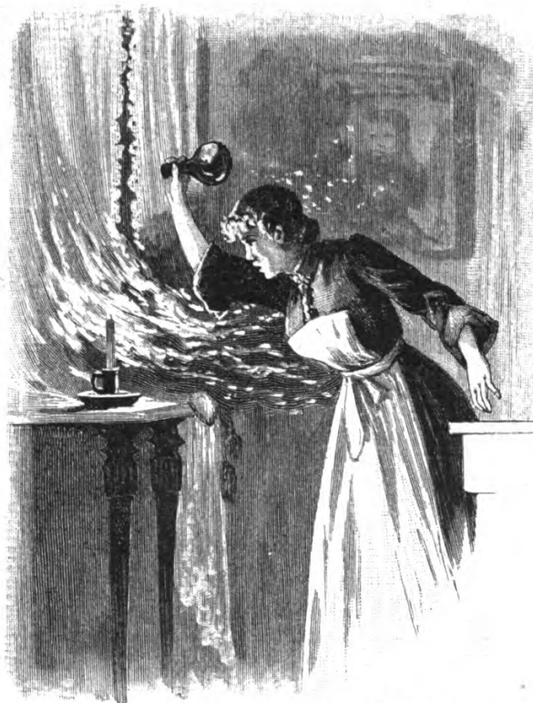
Löschten eines Brandes mittels Löschflaschen.
