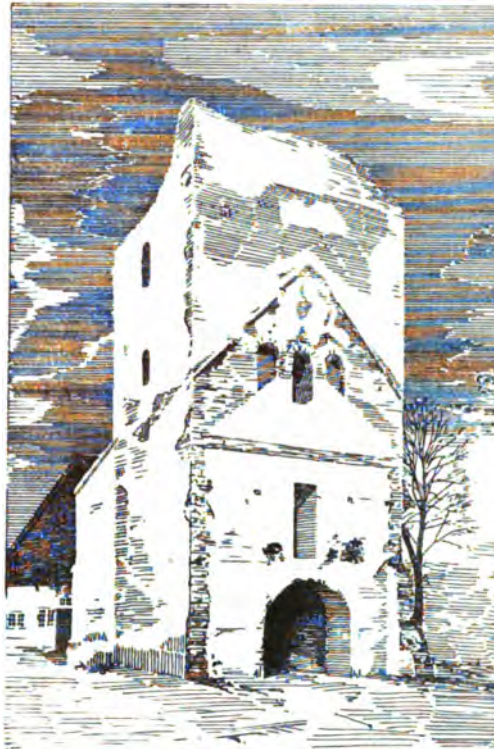
Kirch-Thurm beim Abbruch.
