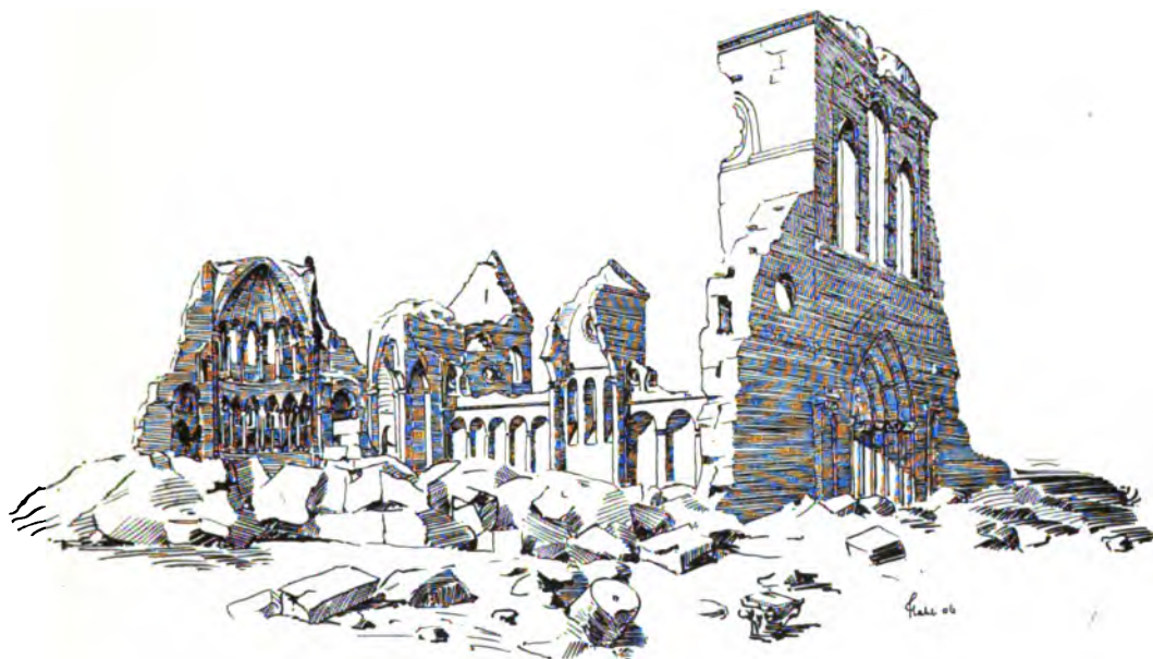
Fig. 31. Heisterbach. Die Klosterkirche während des Abbruches.
