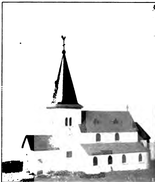
Fig. 266. Witterschlick. Die ehemalige kath. Pfarrkirche.
