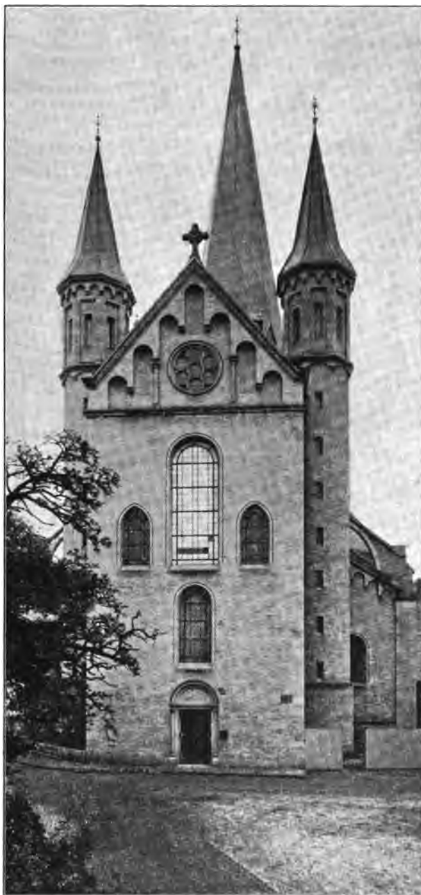
Fig. 19. Bonn. Der Westchor des Münsters nach der Wiederherstellung.
