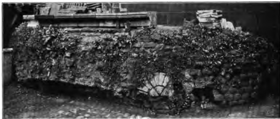
Fig. 59. Köln. Rest eines römischen Turmes an der Nordseite des Domlanghauses.
