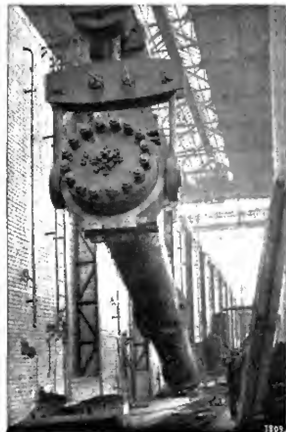
Abb. 229. Hochdruckofen der I. G.
