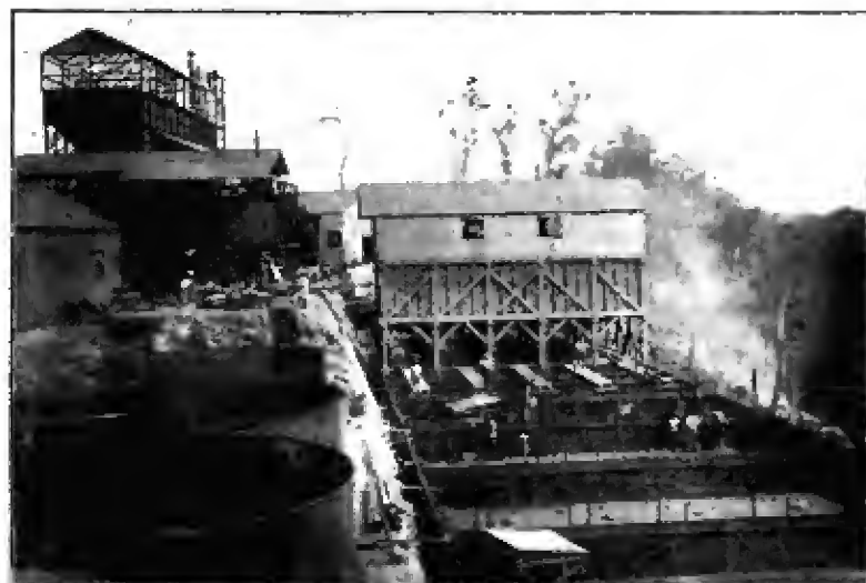
Abb. 11. Cyanidanlage der ABBONTIAKOON BLOCK I LTD. mit Laugebottichen für Sande im Bau.
