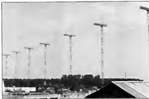
Мачты радиостанции постановки помех (РПП) в Балашихе, Московская обл.
