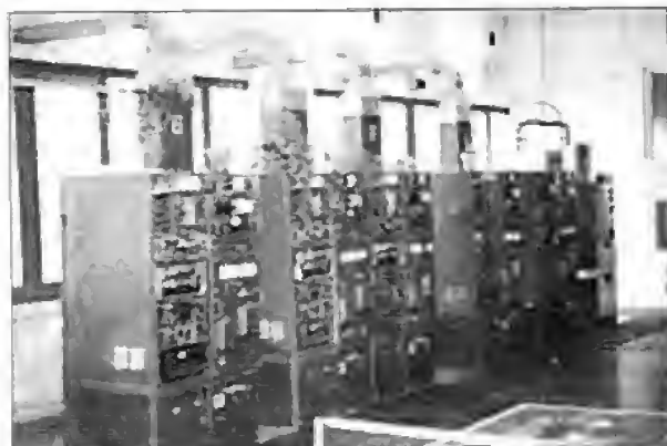
Аппаратный зал объекта № 1656 (Паневежис, Литва): пять из десяти передатчиков «Вязь-2М-ОП».
