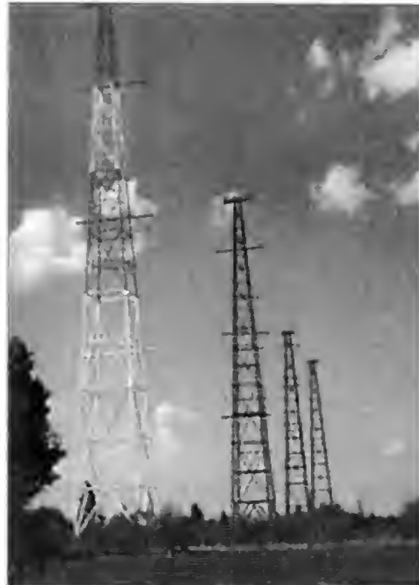
Четыре башни высотой 85 и 65 м, между ними – 3 антенны «СГД» для диапазонов 16/19, 25/31 и 41/49 метров на радиостанции Ситкунай в Литве. Азимут 259° – для иновещания на Западную Европу, 79° – для вещания или глушения на Россию и Кавказстан.
