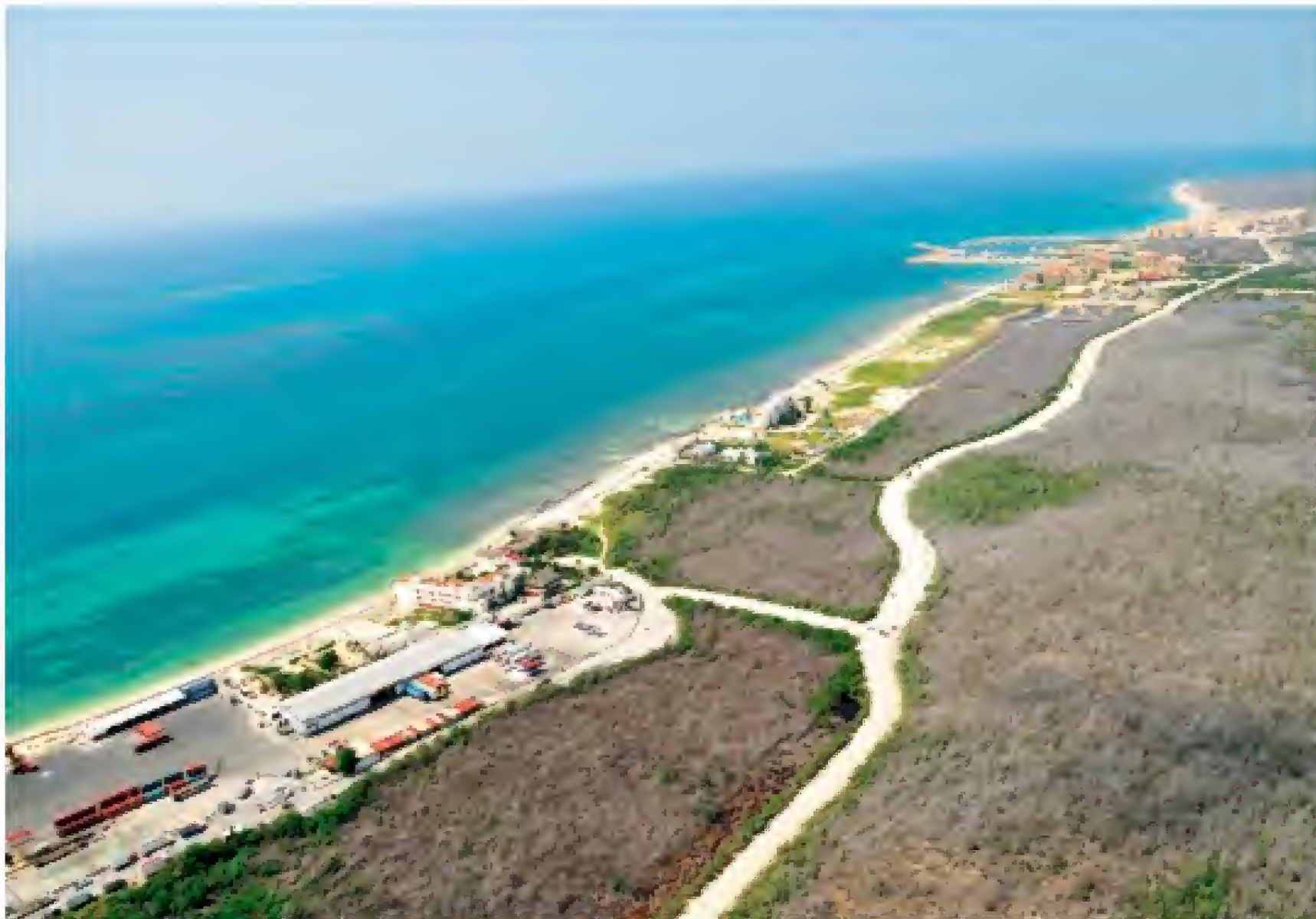
FIGURA 1.12 Manglar que muestra los efectos posteriores al paso de un huracán aunado a modificaciones hidrológicas por la construcción de infraestructura carretera y hotelera, Quintana Roo.
