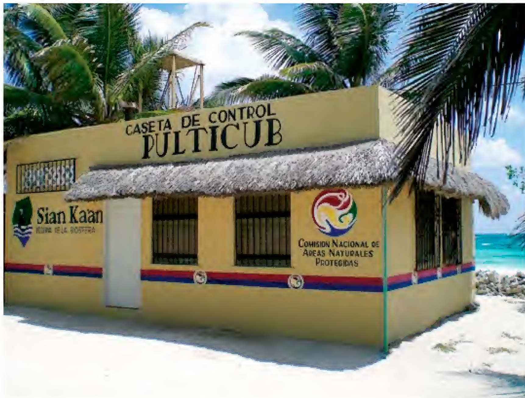
FIGURA 2.9 Caseta de control Pulticub de la Comisión Nacional de Áreas Naturales Protegidas en la Reserva de la Biosfera de Sian Ka'an, Quintana Roo, en la cual una parte importante de su cobertura es manglar.
