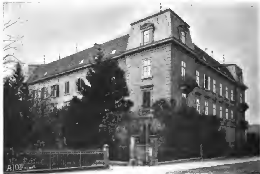
Haus an der Hottingerstrasse Nr. 30.
