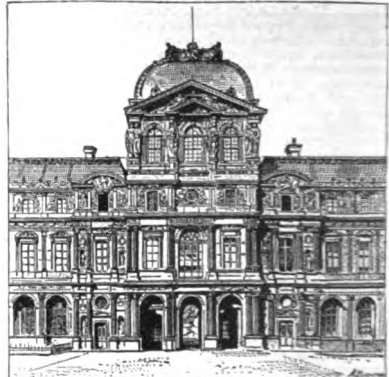
Le Louvre (fragment du vieux Louvre; le Pavillon de l'Horloge).
