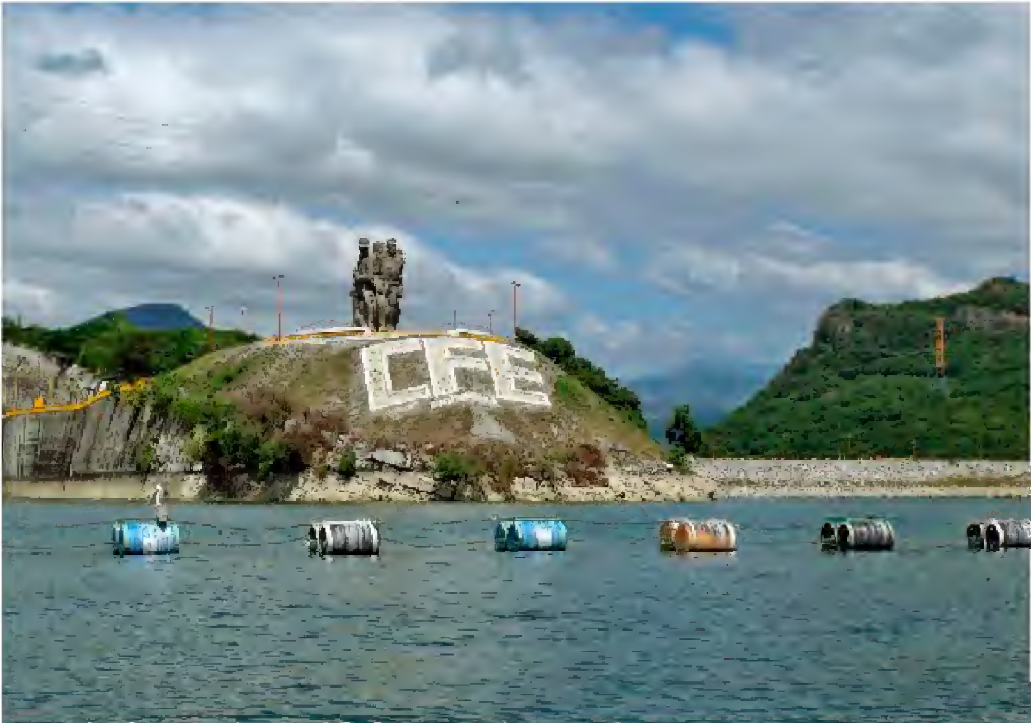
Figura 3.7. Presa Manuel Moreno Torres "Chicoasén" Estado de Chiapas. Fotografía: Gabriel Barrios Quiroz
