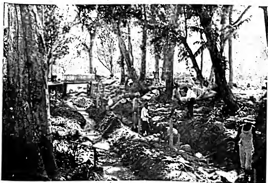
Dois aspectos dos trabalhos de restauração do Jardim Botânico, em Agosto de 1937. (Photos Lacerda).
