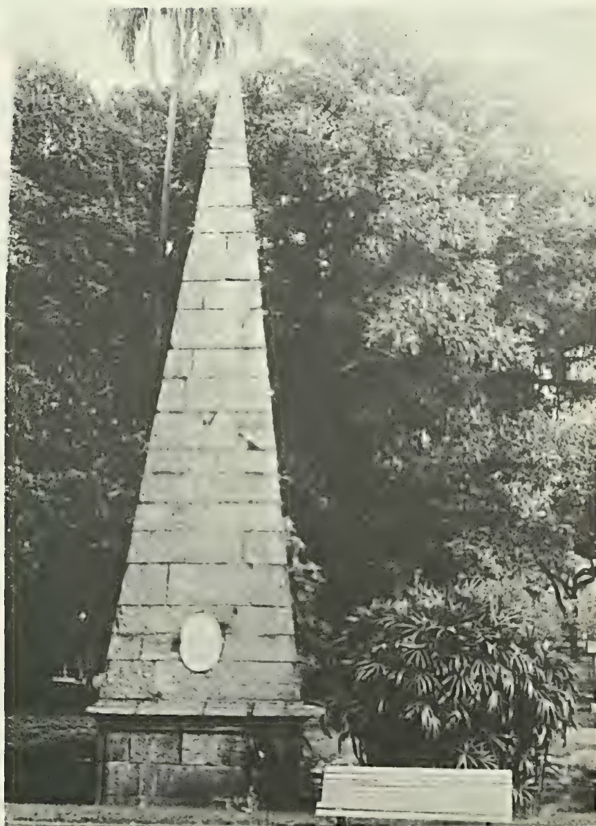
Uma das pirâmides já desprovidas completamente da hera
