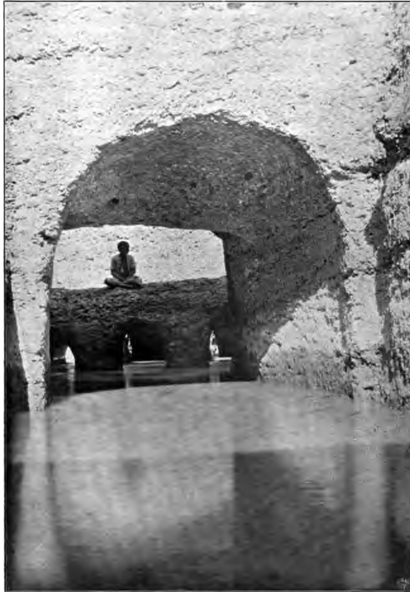
„Ngüb“-Tunnel zur Ableitung eines Canals aus dem großen Zab nach Kalach-Nimrud, in Assarhaddons Neugestaltung.
