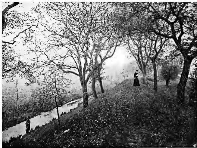
11. La digue du Groot Schoor, plantée de Noyers ( Juglans regia ). La dame de droite est au niveau de la dernière laisse de marée; le jeune homme de gauche est au niveau du polder.
