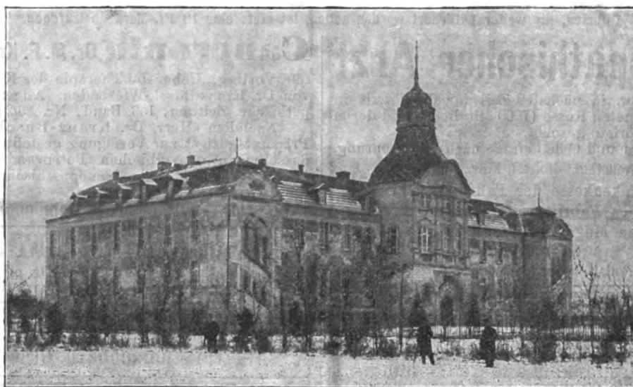
Berliner homöopathisches Krankenhaus Gross-Lichterfelde-West Carstenstrasse.
