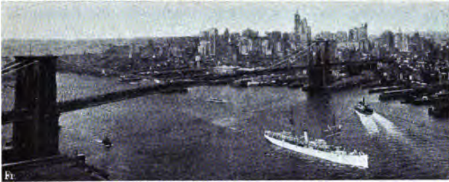
Brücke nach Brooklyn
