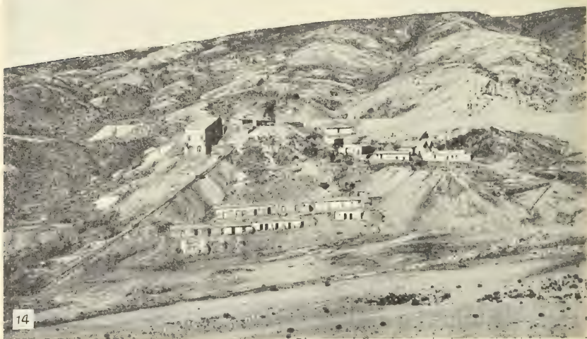
Figs. 13 y 14. — Casas e instalaciones de la mina « Concordia », territorio de Los Andes
