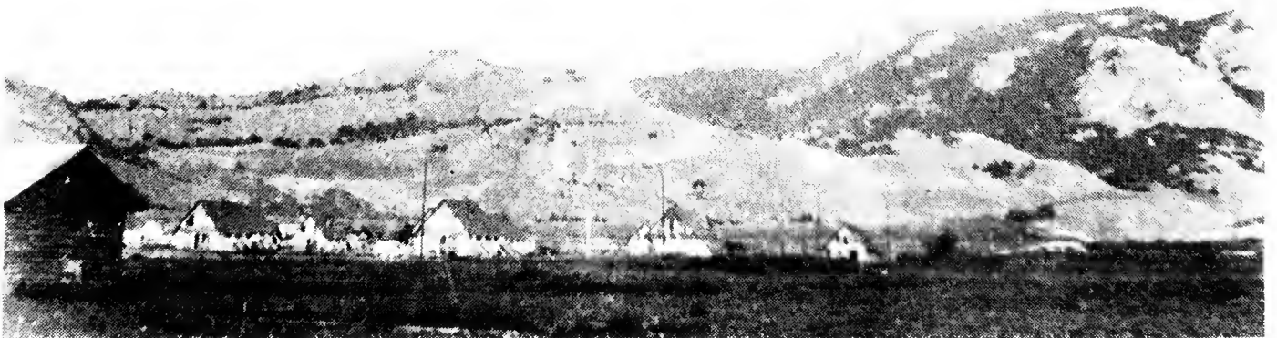
Foto N° 20: Valle del Chaltén. Barrio de 13 casas construídas por la Provincia de Santa Cruz. Vista hacia el Oeste. Al fondo el Cerro Fitz Roy y parte del alineamiento Oriental de la Cordillera Principal. En el centro las Sierras de Transición.
