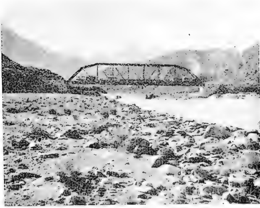
Puente 75 metros de luz, kil. 58.750
