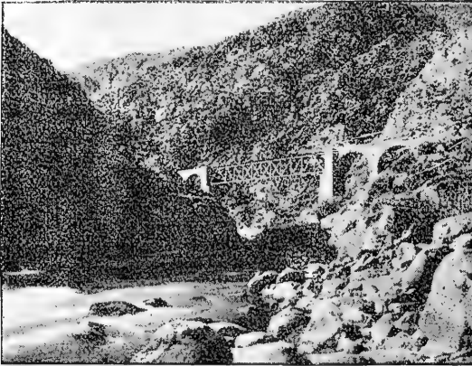
Puente 45 metros de luz, kil. 36.700
