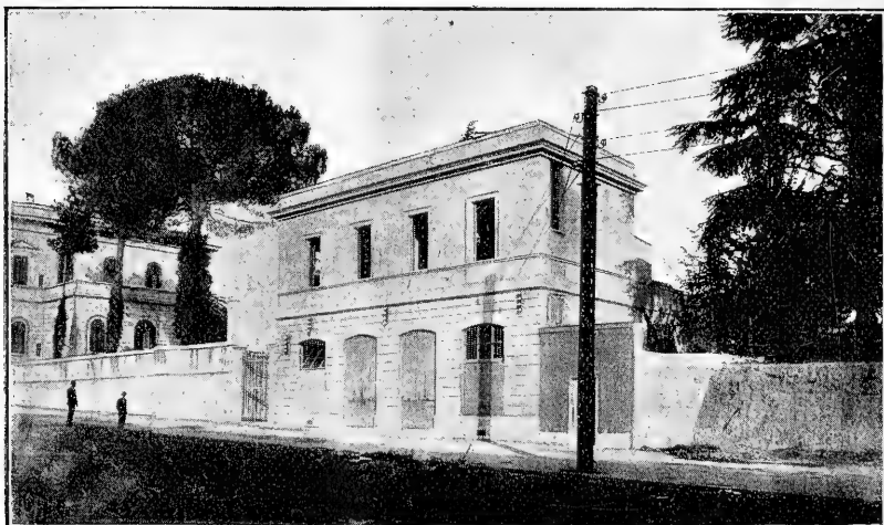
Fig. 5. — Estación Porta-Pia : último poste de la línea Tivoli-Roma
